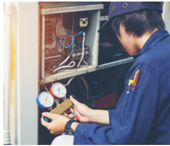
WARTUNG UND REPARATUR
