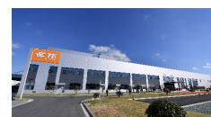
昆山工場 Kunshan Plant
