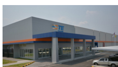
ゲートウェイ工場 Gateway Plant
