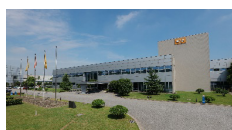
蘇州第1工場操業 EPZ Plant
