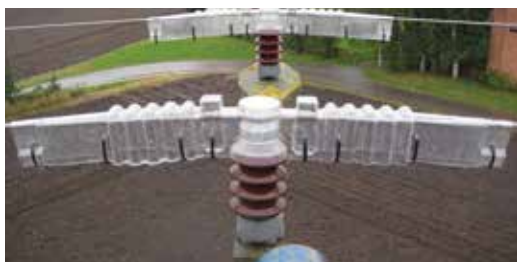
BCIC-1217-TR : Application d'isolation sur isolateur
