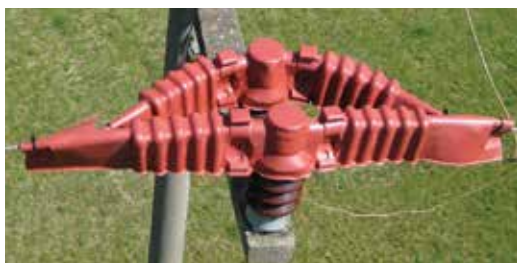
BCIC-1215 : Application d'isolation sur double isolateurs
