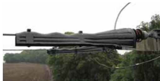
BCIC-TEN-01 : Application d'isolation d'ancrage
