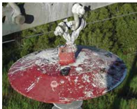
Coupelle de protection sur isolateur composite
