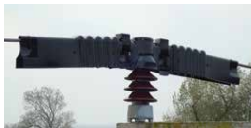
BCIC-1219-PE : Application d'isolation sur isolateur
